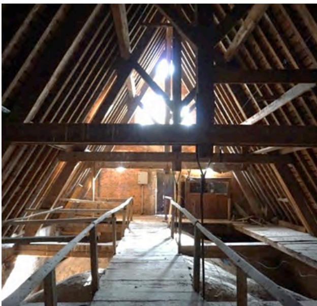
Vue générale des combles de la nef
