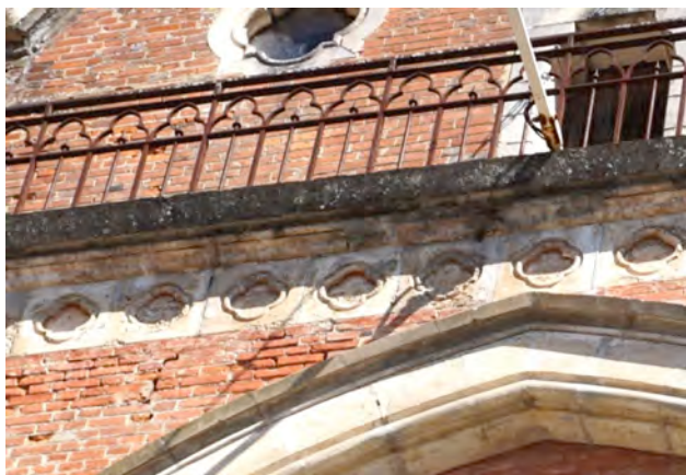
Détail de la frise et des ferronneries de la façade Sud
