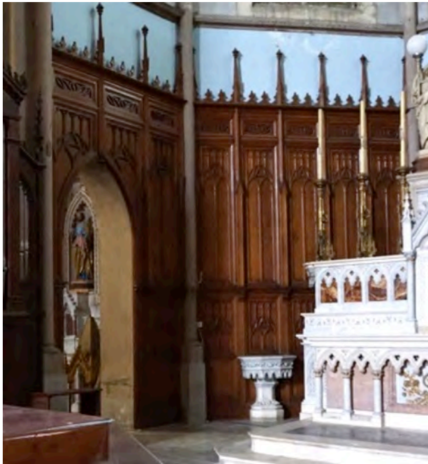
Boiserie de hauteur habillant l'ensemble de l'abside du chœur
