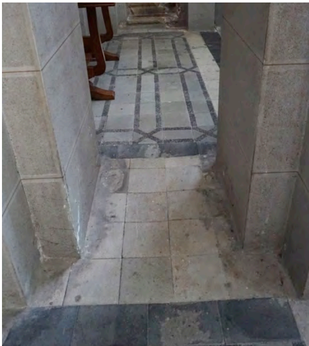
Détail des déformations du sol au niveau du bas-côté Ouest
