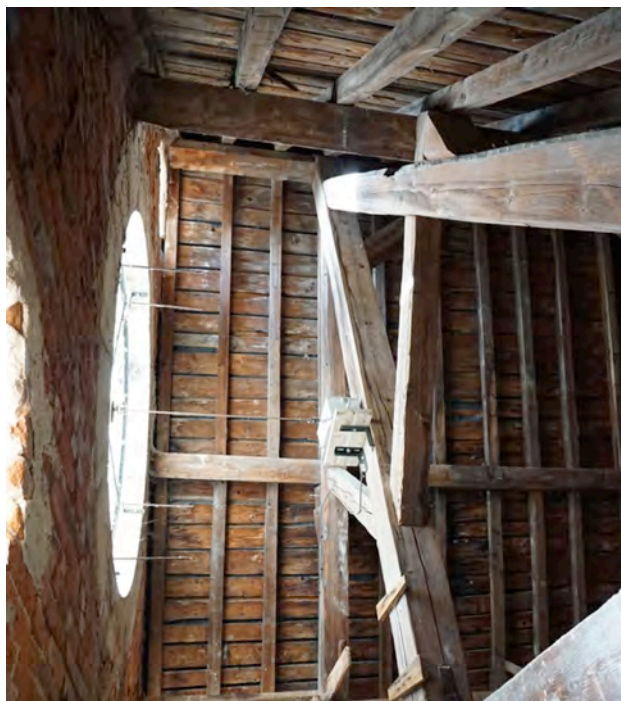
Vue générale des combles de la nef
