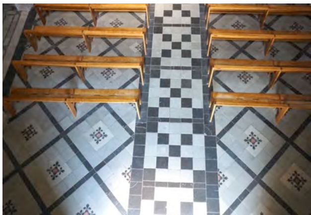
Détail du sol de la nef
