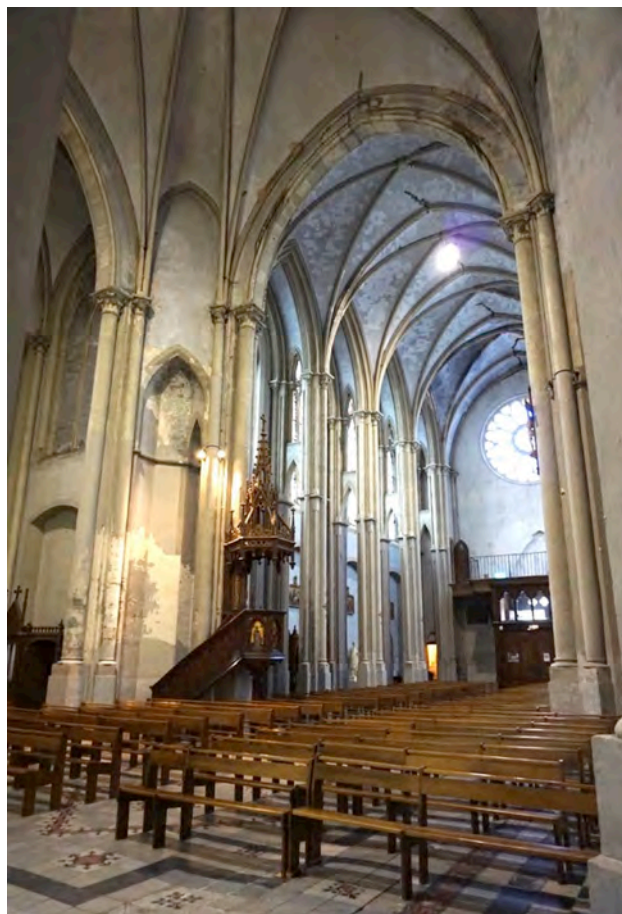
Vue de la nef et de la croisée du transept
